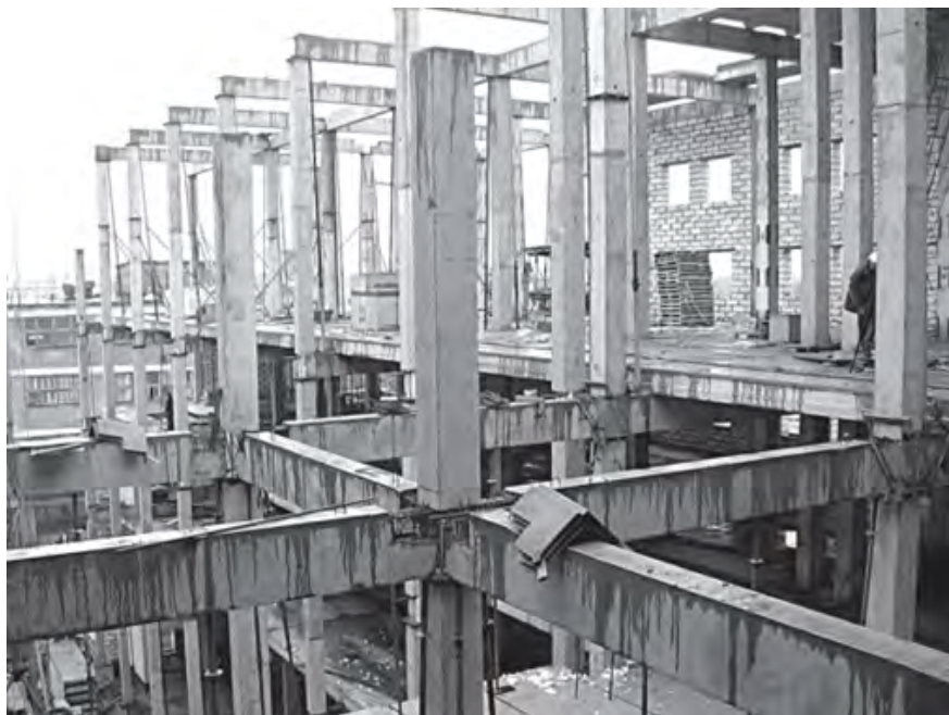
Рисунок 153 – Возведение несущего каркаса здания с бесстычковыми колоннами и ригелями (типа «Saret») из бетона классов В25-В35, марок по прочности D1750-D1850 на высокопрочном керамзитовом гравии производства Новочебоксарского ДСК (г. Казань)
